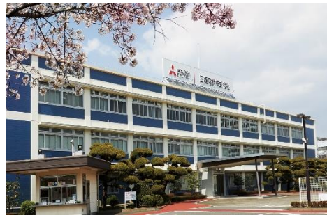
Závod Nagoya Works
